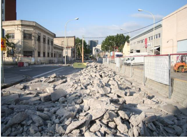
1. Aixecament del paviment UE 1.
