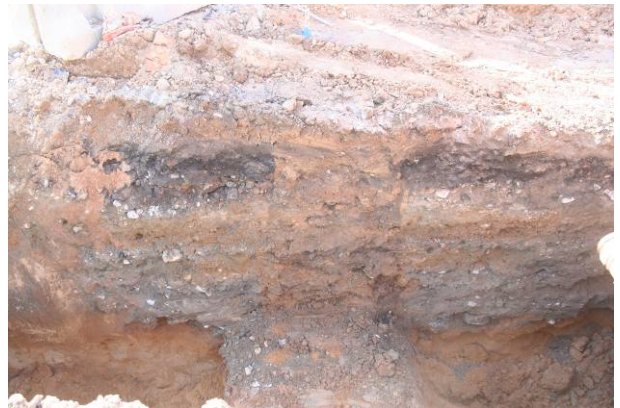
22. Rasa 2, alçada núm. 446 del Carrer de Pere IV. Es pot observar la rasa per a la instal·lació d'un servei.
