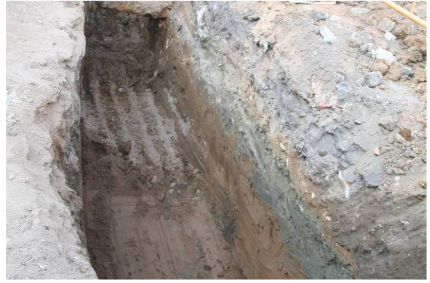
10. Rasa 2, alçada núm. 420 del Carrer Pere IV
